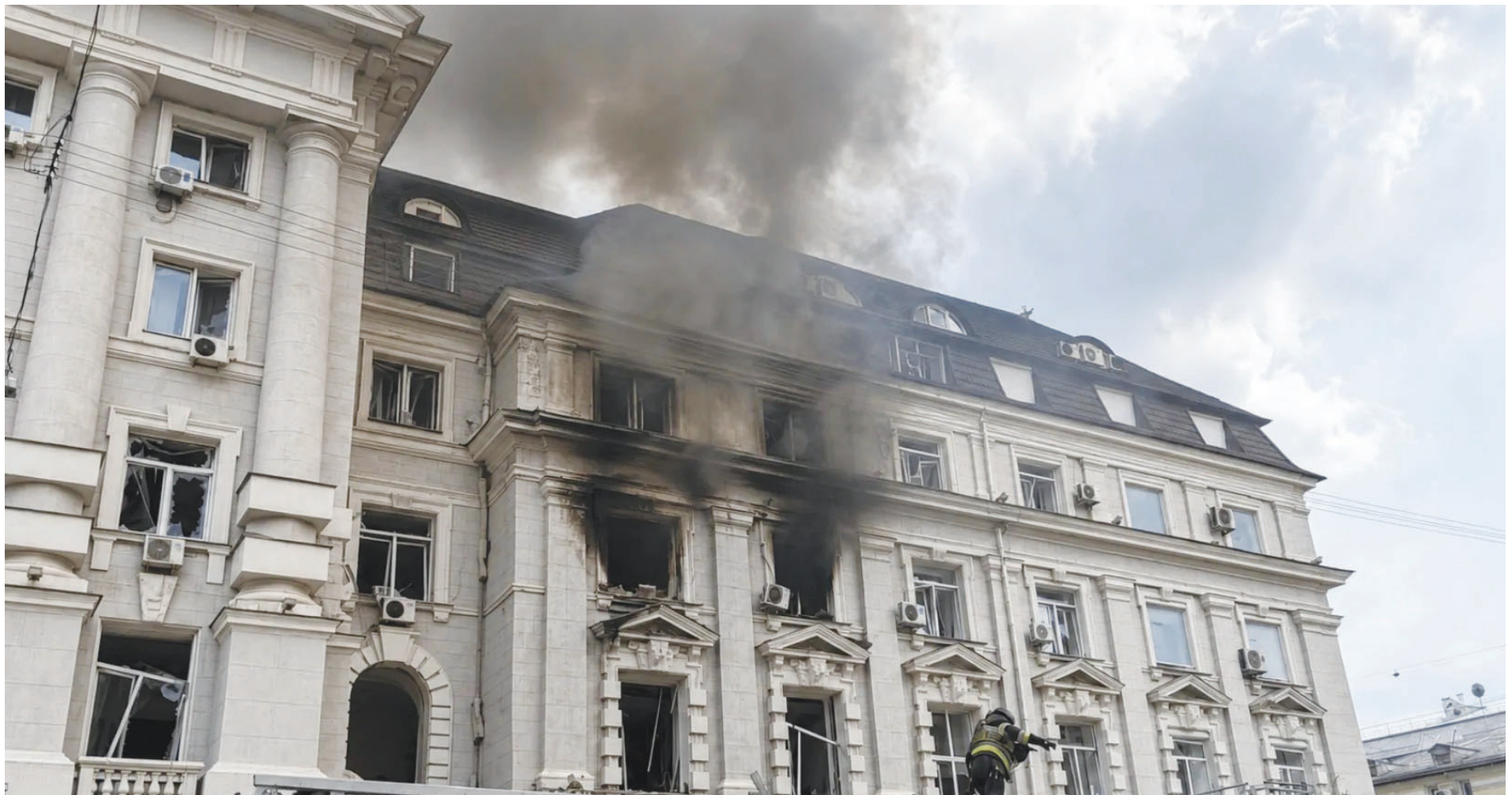
Пошкоджена будівля СБУ, 4 вересня 2026.
