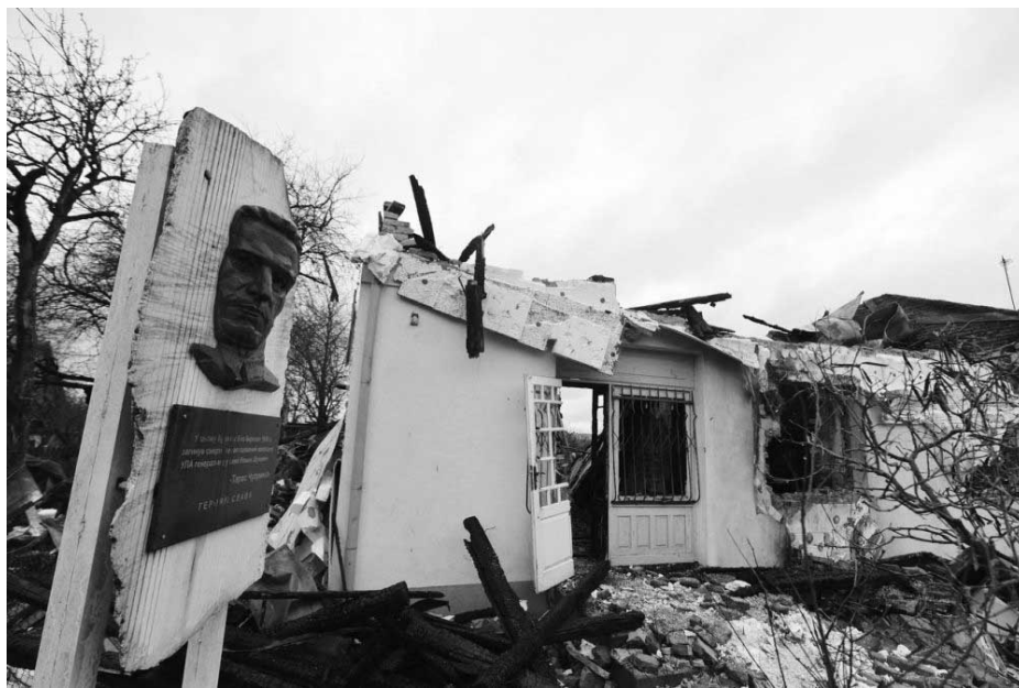
Зруйнована будівля Музею Романа Шухевича у селі Білогорща поблизу Львова після російського ракетного удару 1 січня 2024 року.
