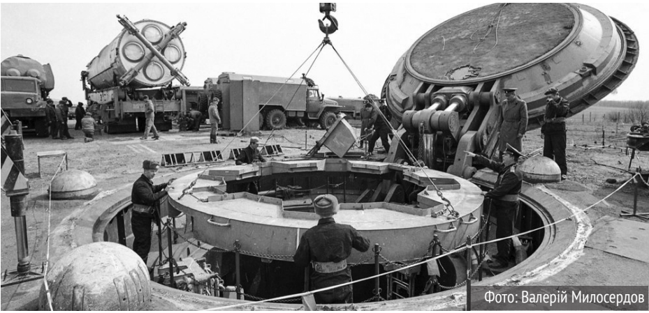
Ракетні війська стратегічного призначення ЗС СРСР. Демонтаж ядерної ракети СС-19. Шахтна пускова установка з відкритим люком і ракетою, підготовленою до демонтажу. Первомайськ, Миколаївська область, березень 1994
