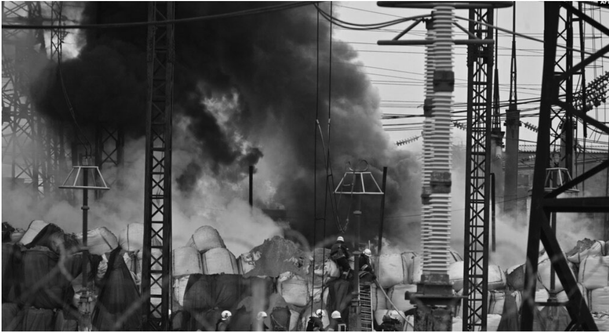
Пожежники гасять пожежу на електропідстанції після ракетного обстрілу в Харкові, 22 березня 2024 року. (Фото: Сергій БОБОК / AFP)
