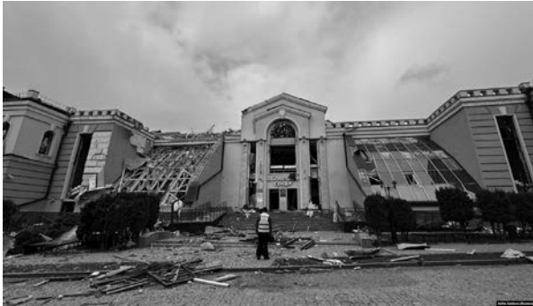
Пошкоджена обстрілом будівля Сумського державного університету.
